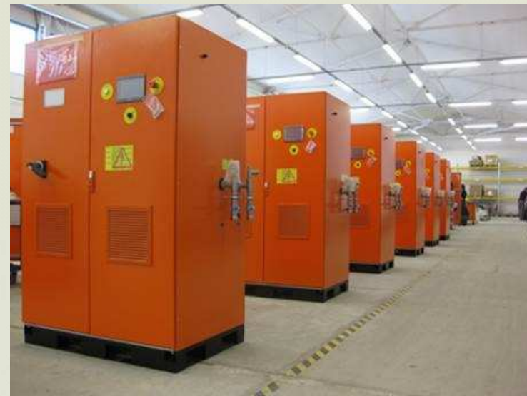
Соларни централни инвертори с мощност 500kW
